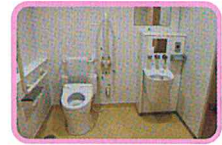
多目的トイレ
